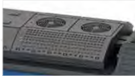
Korrekte Umsetzung der Klimaaggregate auf dem Dach
